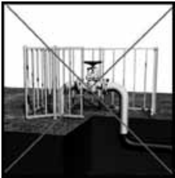
Наземная установка задвижки
