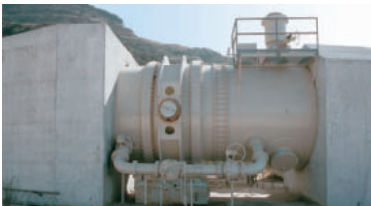
Заслонка аварийного закрытия 3650 мм / 144 дюйма для гидроэлектростанции
