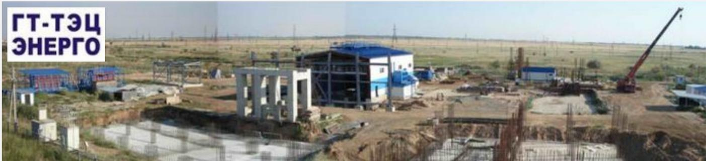
В г.Знаменск Астраханской области продолжается строительство «под ключ» ГТУ-ТЭЦ суммарной электрической мощностью 44МВт. Смонтированы оба энергоблока ЭГЭС-16 «Урал» разработки ОАО НПО «Искра» и производства ЗАО «Искра-Энергетика», установлены генераторы Т-16-2РУХЛЗ разработки и производства ОАО ХК «Привод», смонтировано ангарное укрытие силовых блоков.
