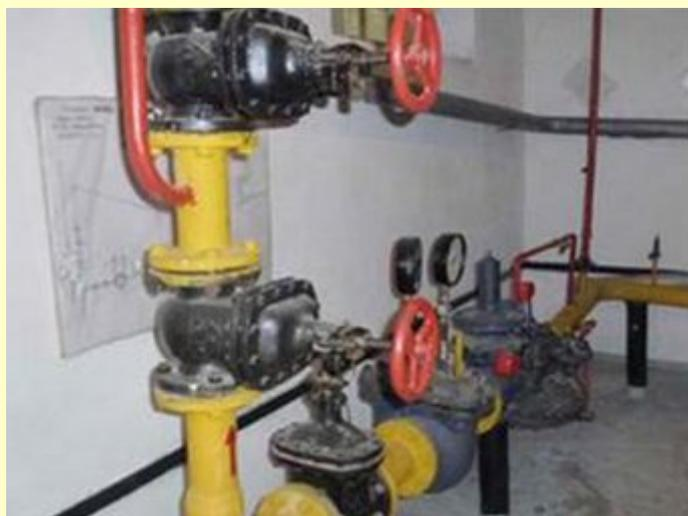
топлива». Также была обнаружена неисправность регулятора давления, основная функция которого – понижение давления газа со среднего на низкое, которое и используются в домах потребителей.
