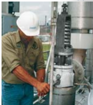
Ремонт клапанов и испытания предохранительных клапанов
